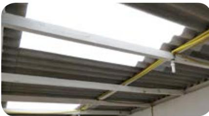
Iluminação com telhas translúcidas economizam 90% de energia elétrica nos ambientes do canteiro
